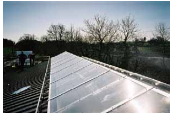
Licht- und Lüftungsfirst Abb. 8
