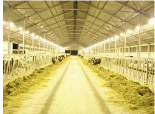
Stallbeleuchtung mit 200 Lux Abb. 1
