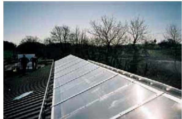
Licht- und Lüftungfirst Abb. 8
